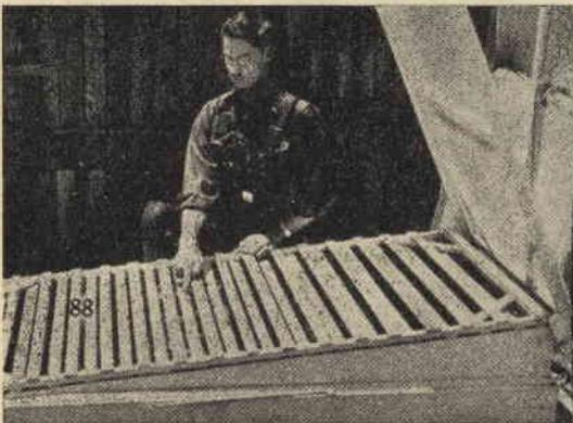
Lo schermo di stecche, con le sue file sfasate permette un massimo di luce solare, anche quando il sole è basso. Quando lo installerete, toglierete lo schermo di mussola
